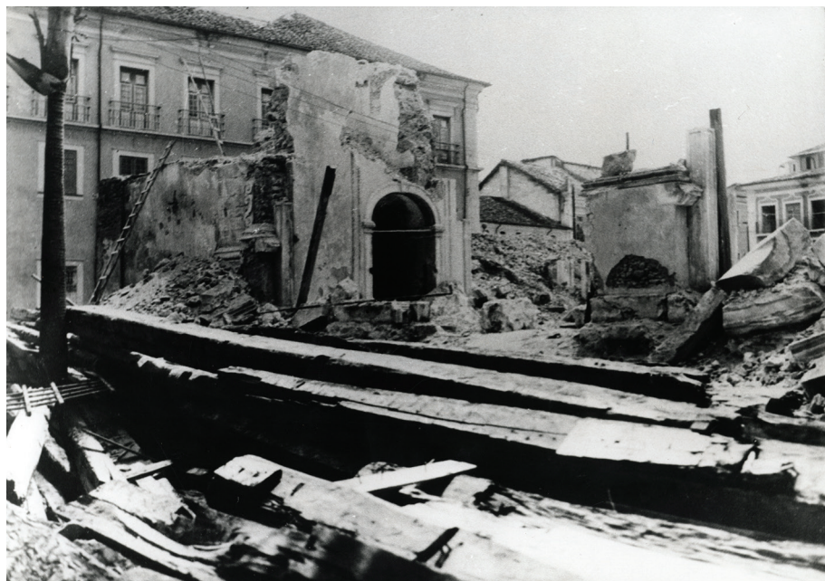
Figura 22 – A demolição da Igreja da Sé - Salvador, em 16/01/1934. Arquivo Histórico Municipal de Salvador/ Secult. Fundo: Prefeitura Municipal de Salvador. Pasta 592 – Documento 503.2. [s.a. na fonte]
